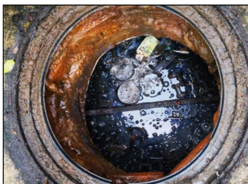
รูปที่ ๑๒ ระบบบำบัดน้ำเสียแบบบ่อกรองไร้อากาศ
