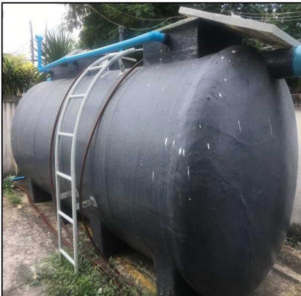
รูปที่ ๑๓ ระบบบำบัดน้ำเสียแบบถังบำบัดน้ำเสียสำเร็จรูป
