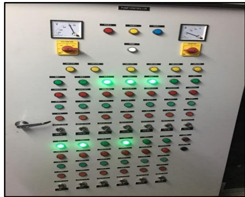
ตู้ไฟฟ้าแสดงการทำงานของระบบบำบัดน้ำเสีย
